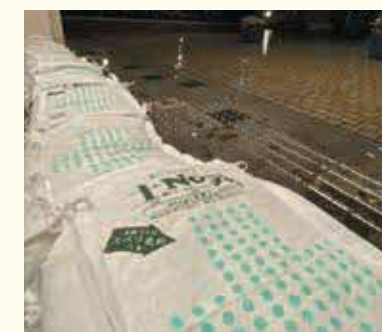
土のうを設置したエントランス
